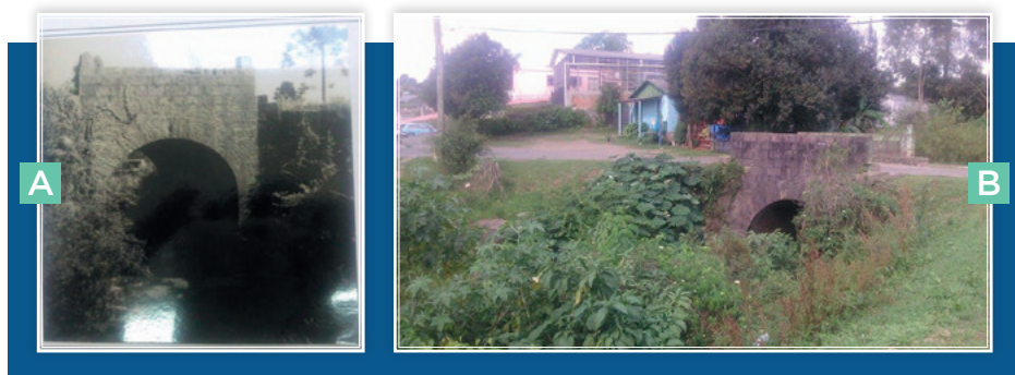
Figura 4 - (a) Ponte sobre o Arroio Bernardina, Soledade (RS), em 1935; (b) Ponte sobre o Arroio Bernardina, Soledade (RS), em julho/2015
