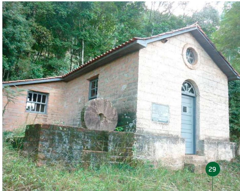
**Figura 3** - Reconstrução com pedras locais da Capela do Núcleo Norte, Ivorá, erguida originalmente em madeira, pelos primeiros colonos na Linha Um.
