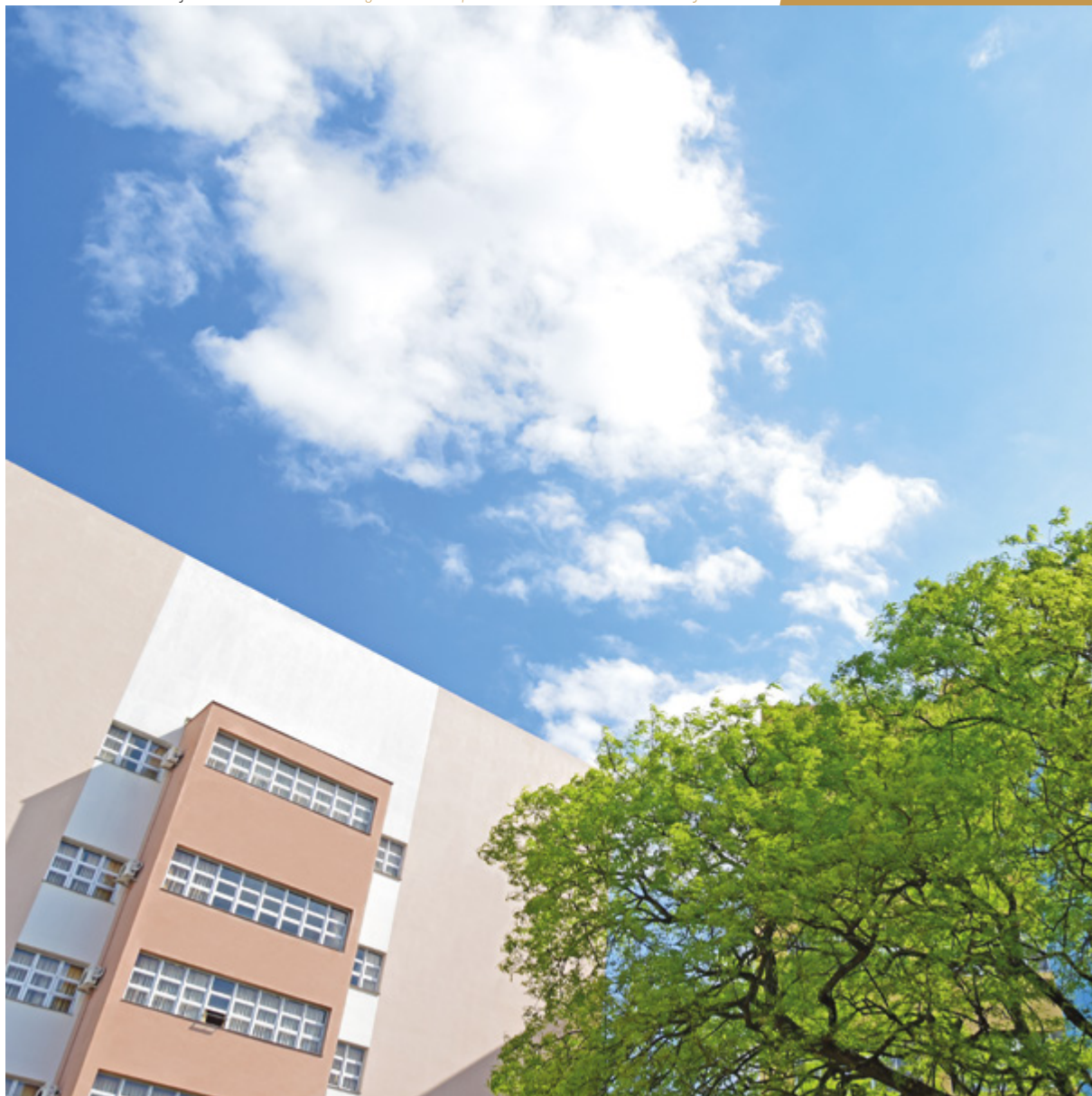
Detalhe do Prédio 16 – Conjunto III / Detail from Building No 16 – Campus III / Detalle del Edificio 16 – Conjunto III
