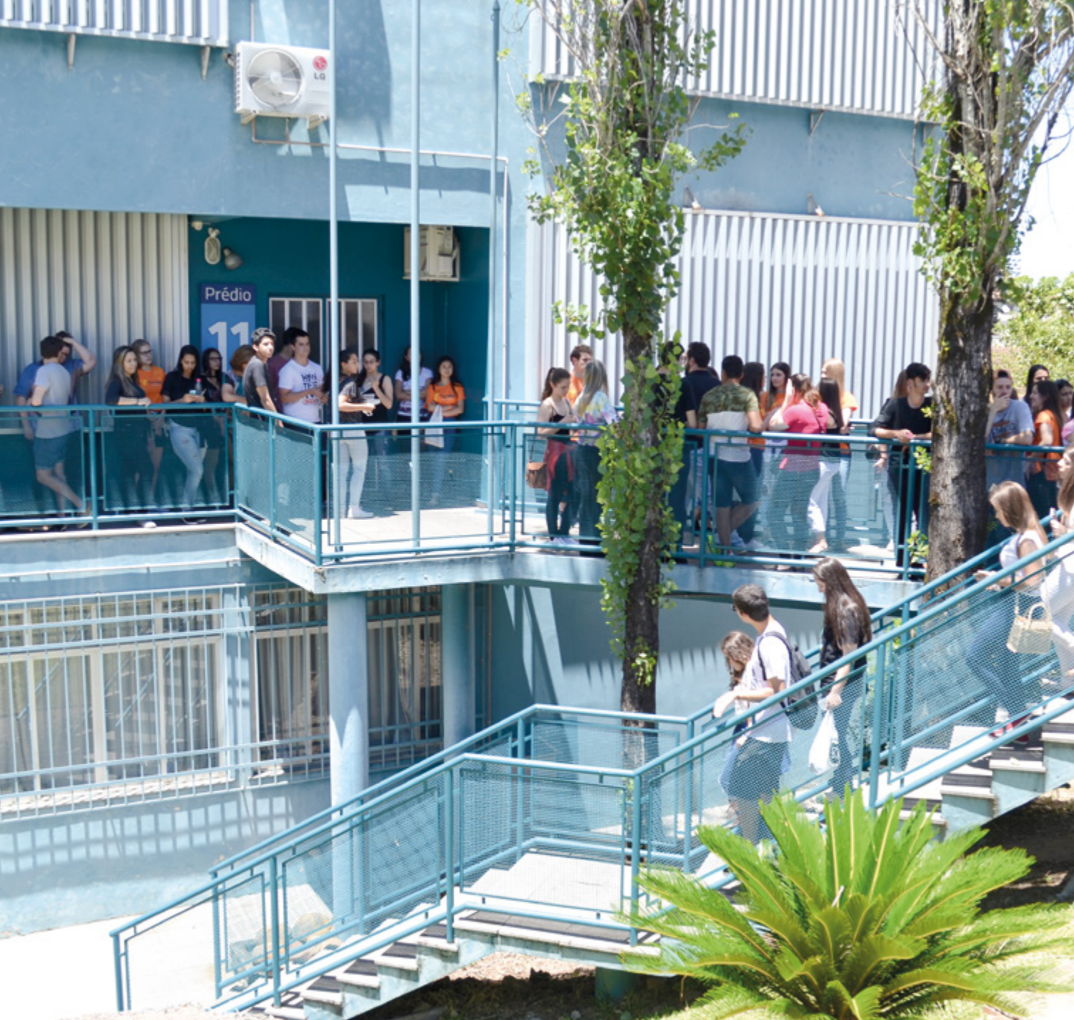
Acesso ao Prédio 11 – Conjunto II / Access to Building No 11 – Campus II / Acceso al Edificio 11 – Conjunto II
