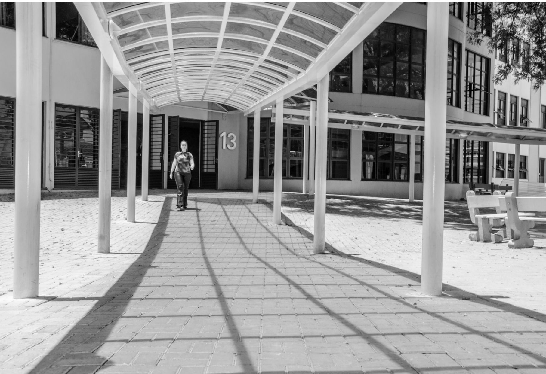
Passarela de acesso aos prédios do Conjunto III
