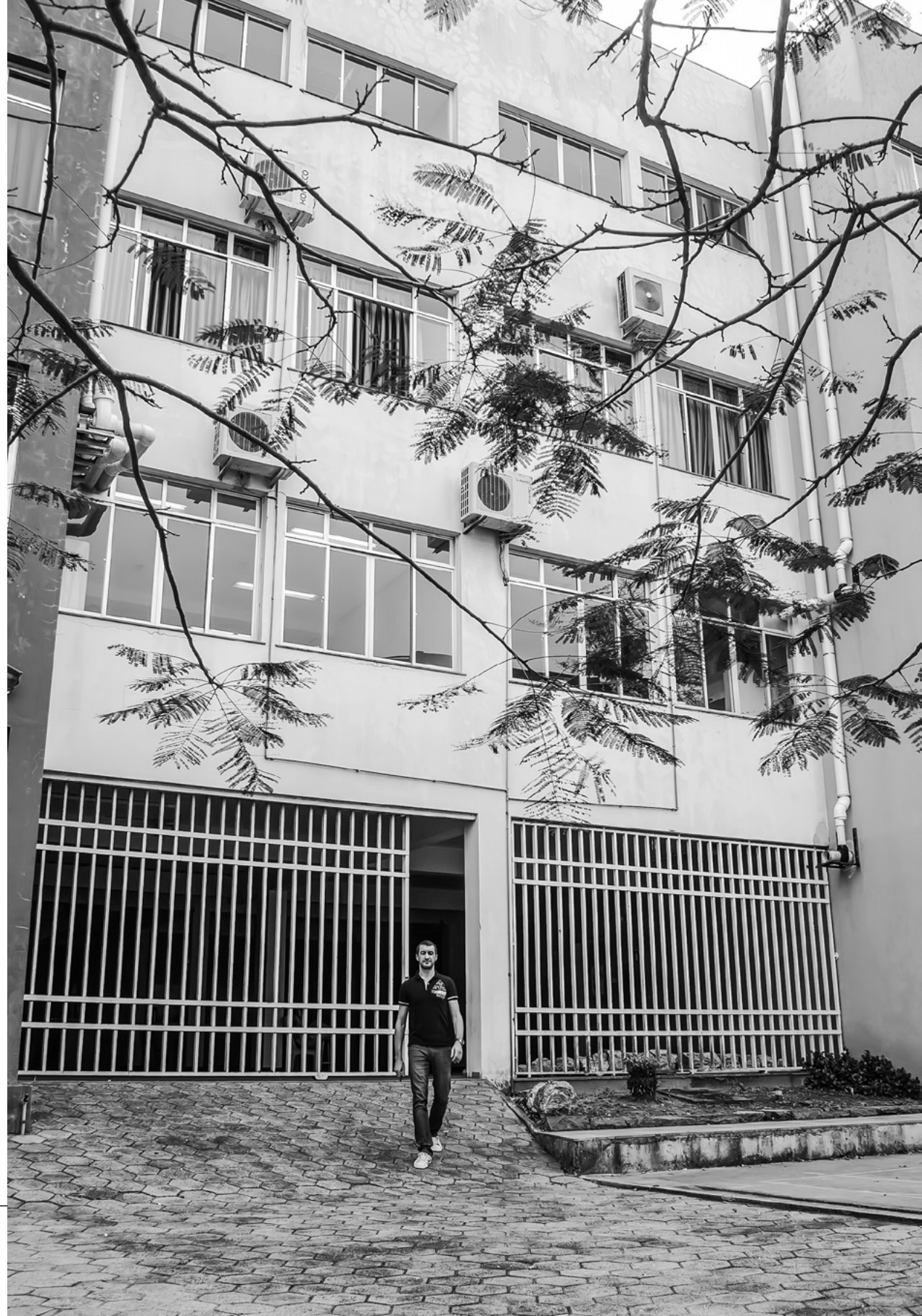
Prédio II - Conjunto II
