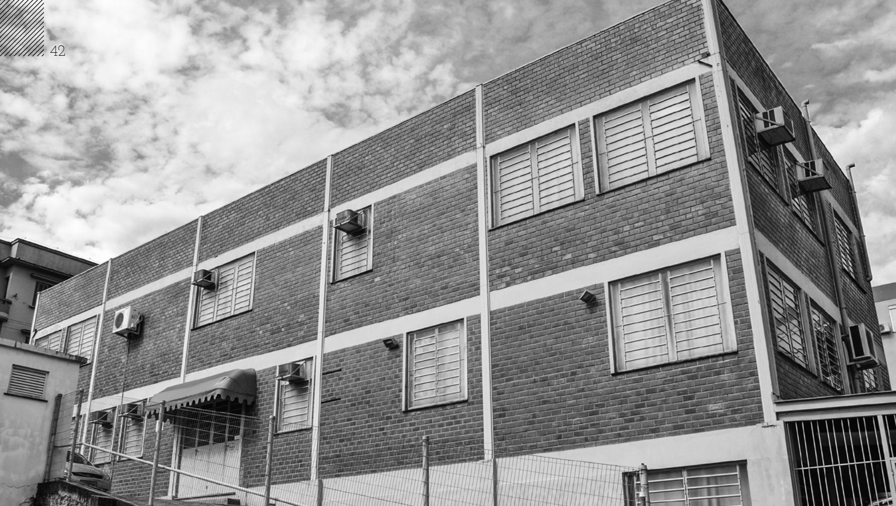
Vista geral do acesso ao Prédio 9 - Conjunto II
