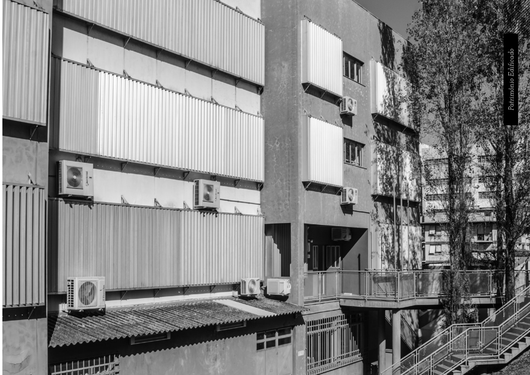
Vista geral do Prédio II - Conjunto II
