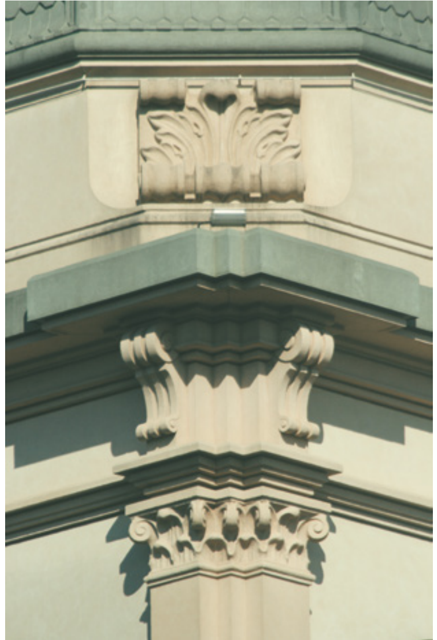
Detalhe de uma das torres | Detalle de una de las torres
