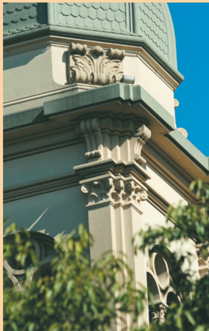
Detalhe de uma das torres Detalle de una de las torres
