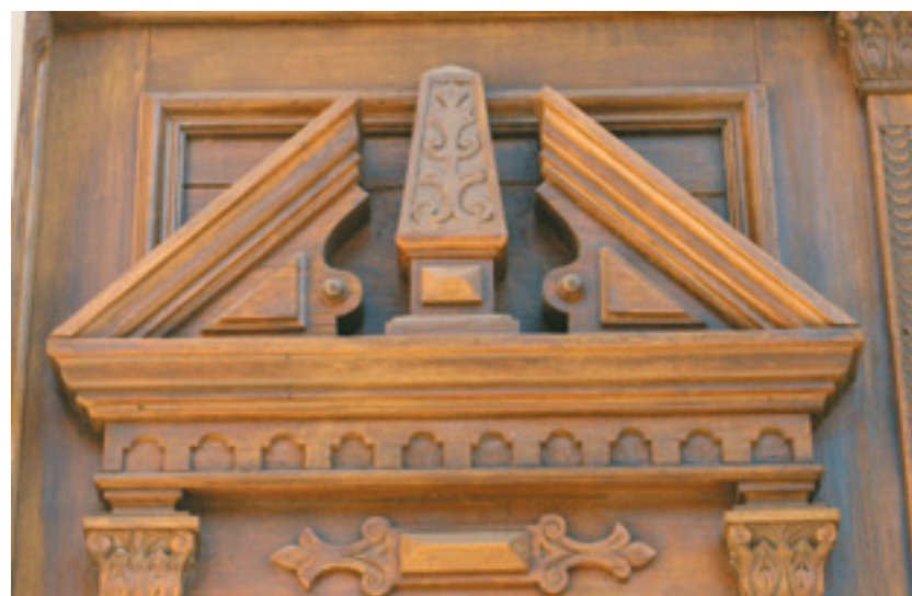
Detalhe da porta principal Detalle de la puerta principal
