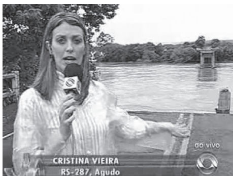
Figura 9 - Restos da Ponte sobre o Jacuí.
