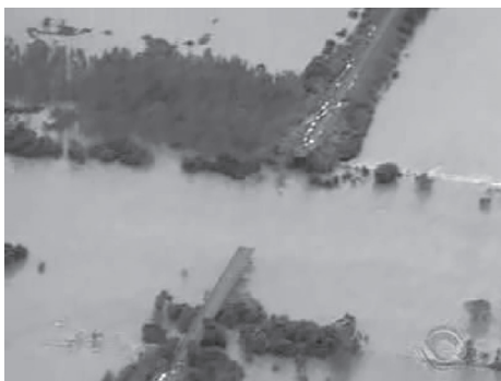
Figura 8 - Ponte sobre o Jacuí: dia da queda.
