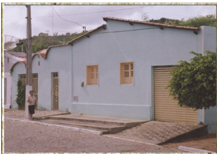
Residência das Irmãs em Santa Brígida
